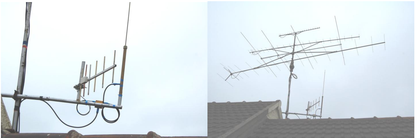
Détails de l'installation (G) et le montage terminé (D), l'un de ces rares jours de grisaille dans le Nord.
